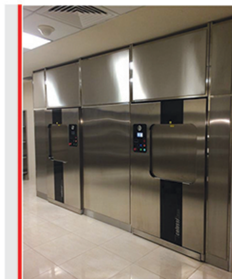
نمونه ای از دیوارکشی استیل بین دستگاه های اتوکلاو
